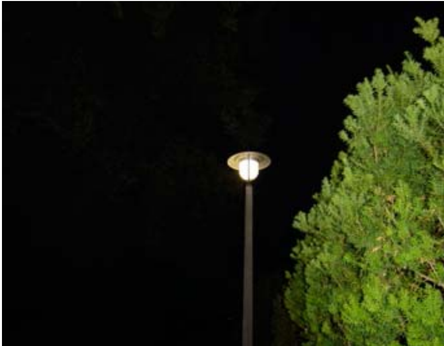
Abb. 22: Nach oben abgeschirmte Strassenlampe am Hollenweg
